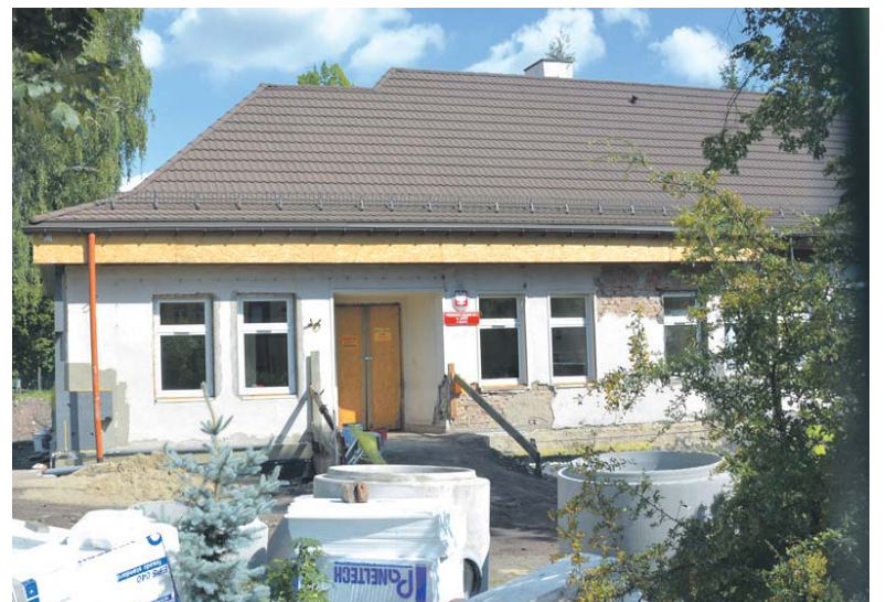
Trwa termomodernizacja budynku Przedszkola Miejskiego nr 6 przy ulicy Wisławy Szymborskiej na Ksawerze.
