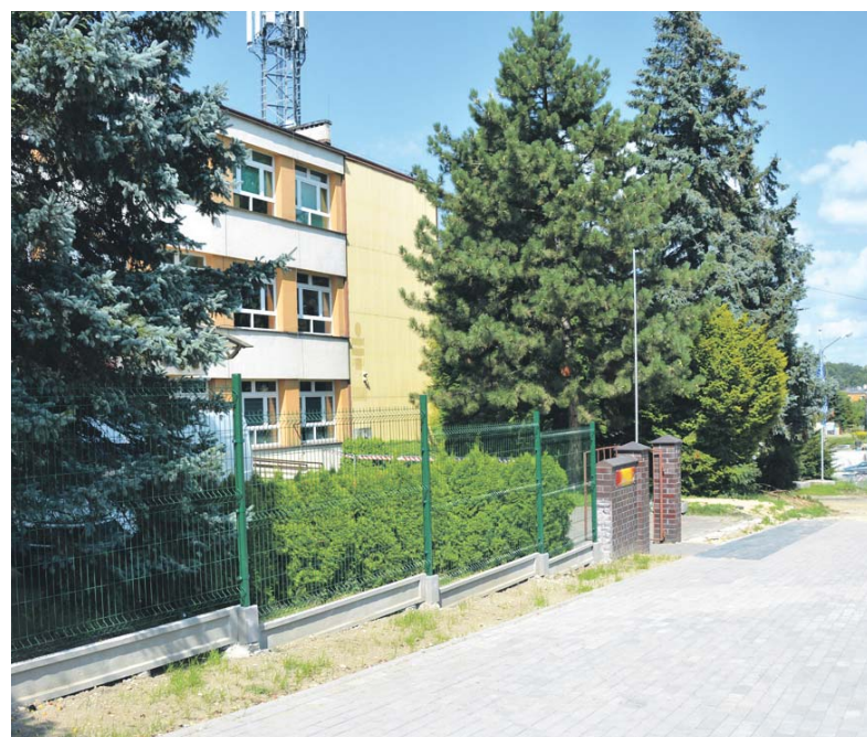
Przy Szkole Podstawowej nr 2 wymieniono przęsta ogrodzenia.
