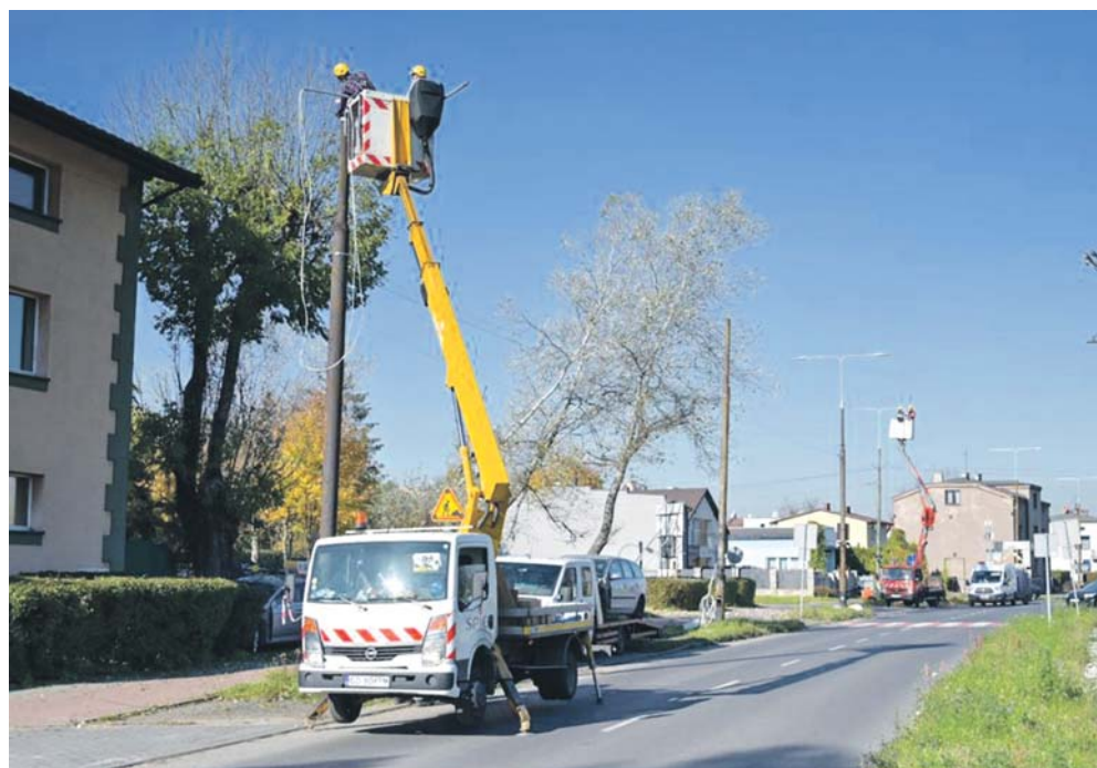
W całym mieście na energooszczędne wymieniane są oprawy oświetlenia ulicznego.
